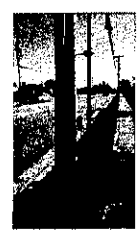
AT&T Riser Pole
